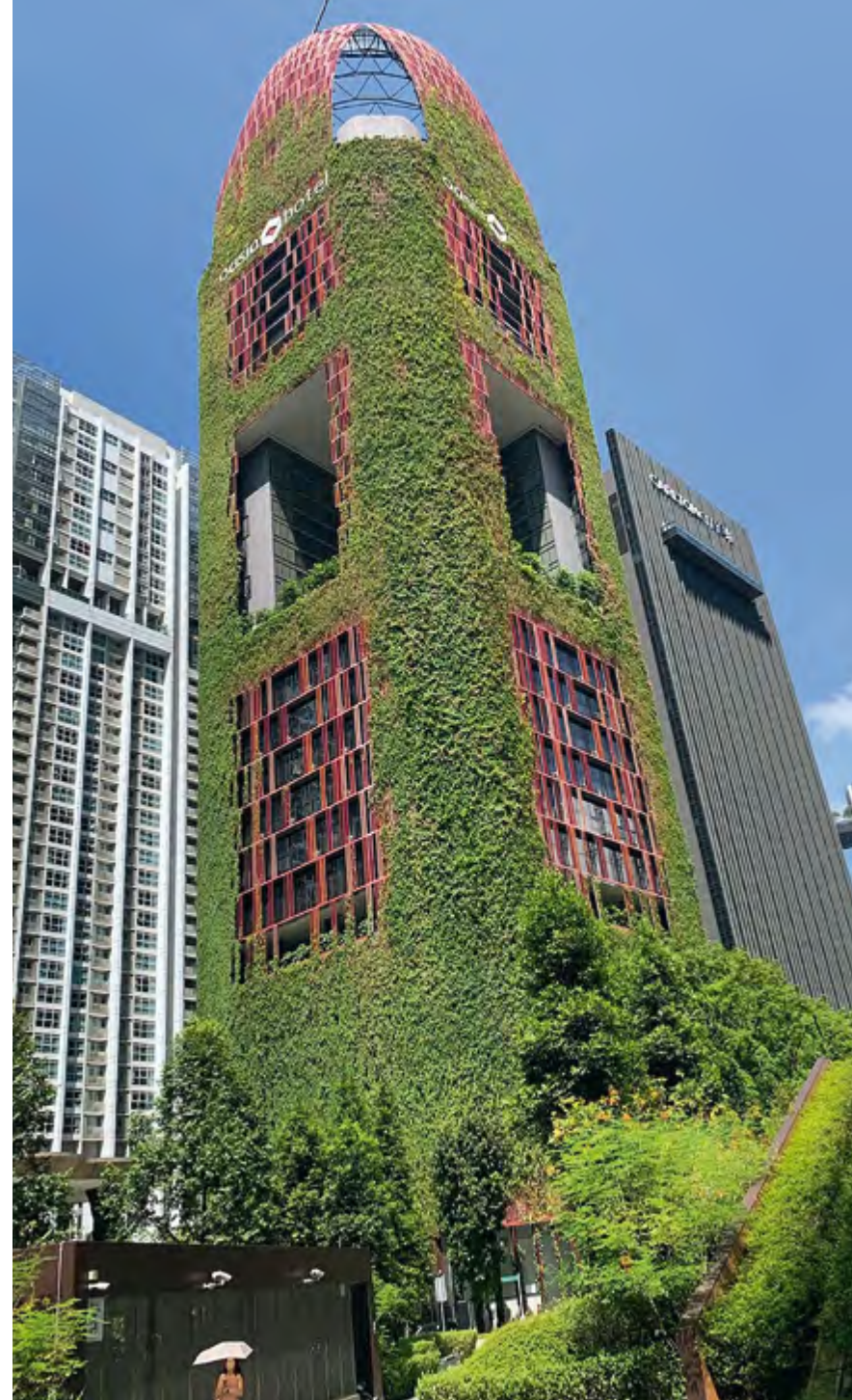
L'Oasia Downtown Hotel, à Singapour, est un gratte-ciel végétalisé de 27 étages qui comprend quatre jardins suspendus.
